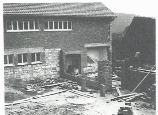
Auf den Grundmauern der einstigen Synagoge entsteht ein neues Schulhaus
