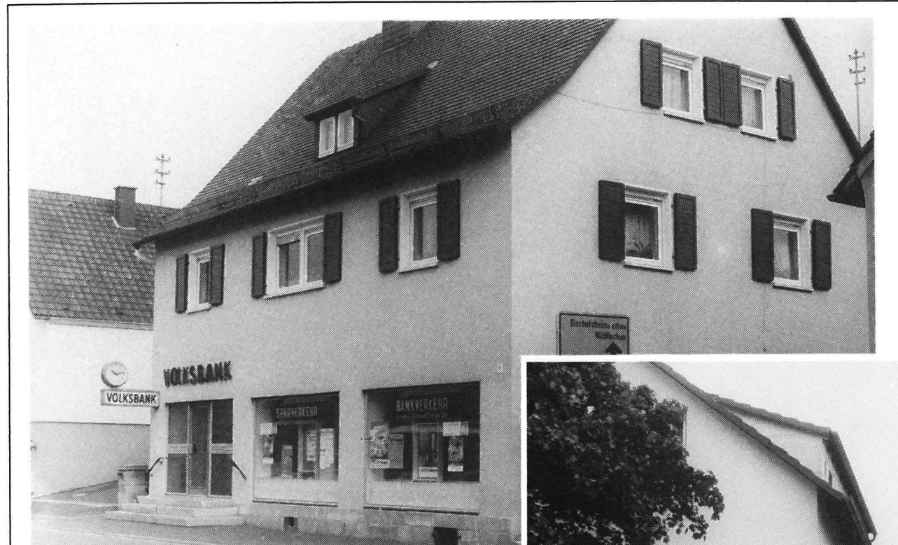
Das Bankgebäude in Steinach, welches in der derzeitigen Form 1966 in Gebrauch genommen wurde.
