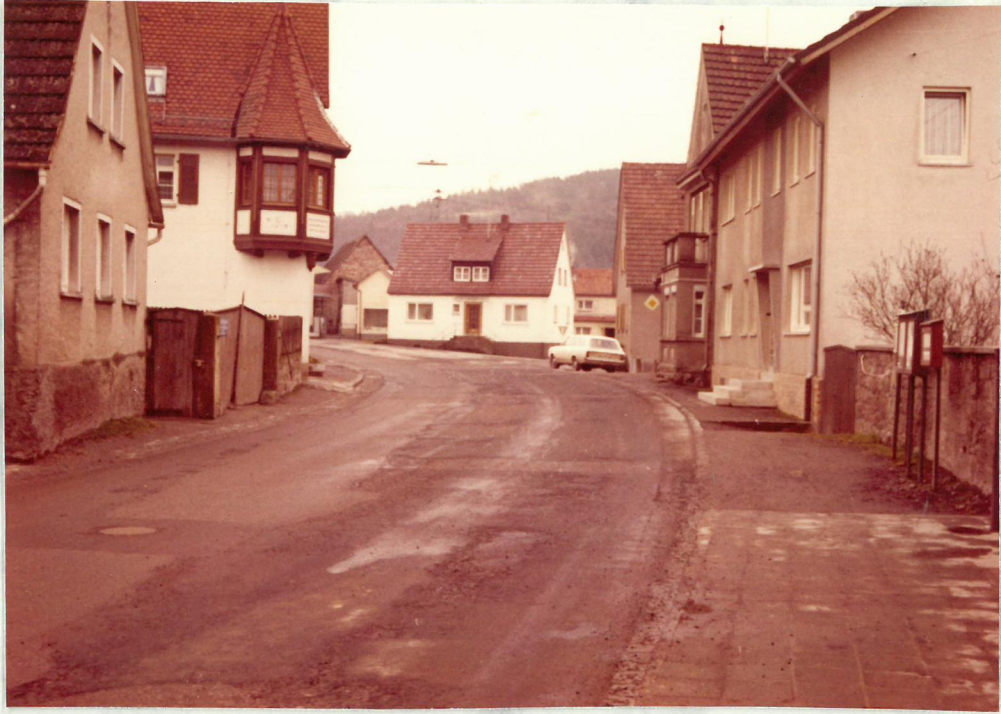
vor dem Ausbau
