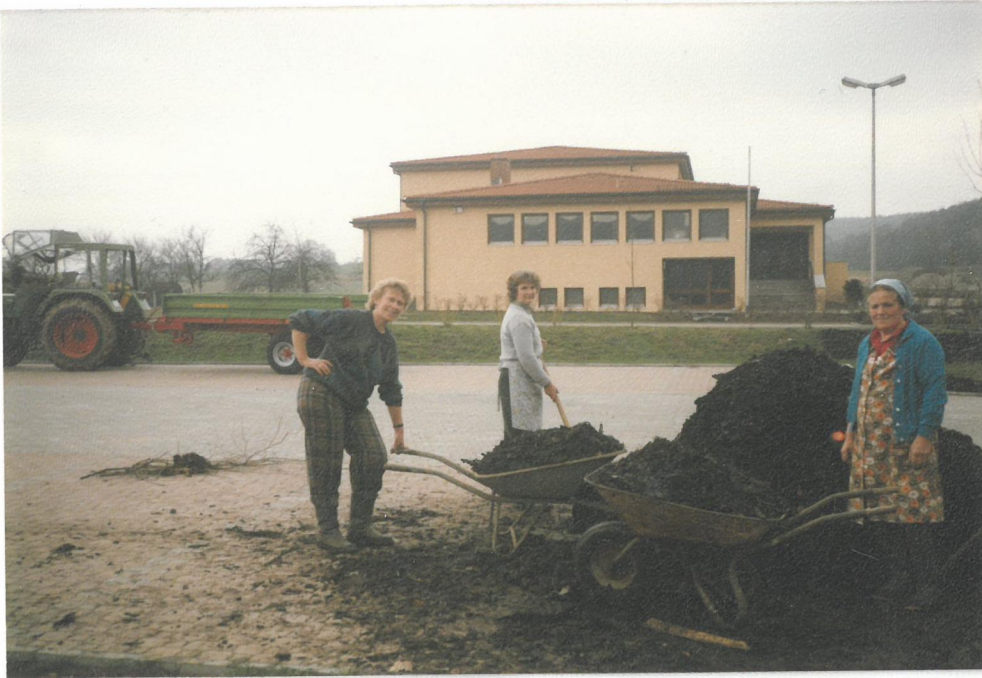
Ob wie hier bei den Restarbeiten an den Parkplätzen der Henneberg-Sporthalle....
